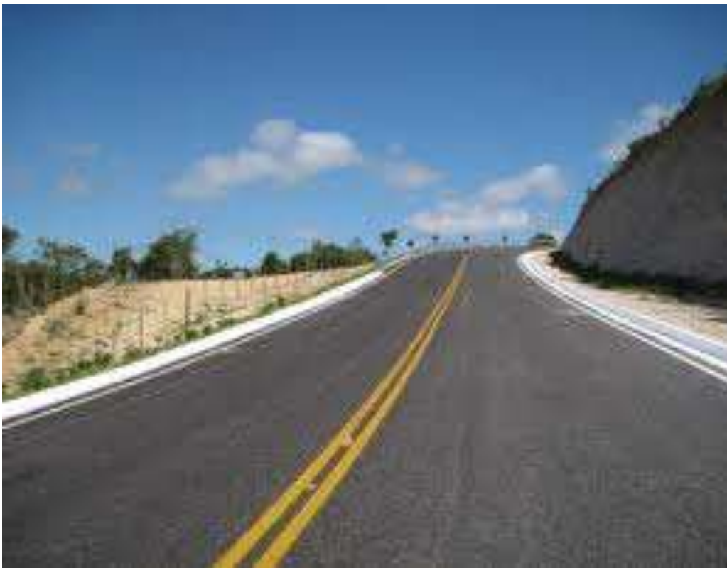
El asfalto con base de goma de neumático es uno de los hitos del reciclaje, minúsculas partículas de goma se mezclan con él para dar mejores propiedades entre las que destaca la
