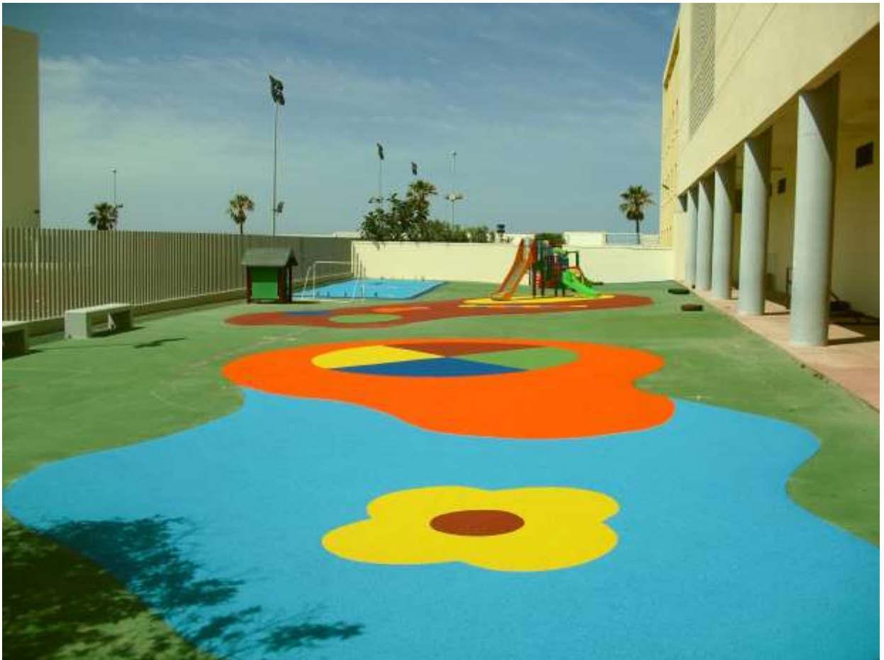
La grana de neumático, con un tratamiento adecuado puede ser utilizada en diferentes tonos y colores en suelo para parques infantiles.
